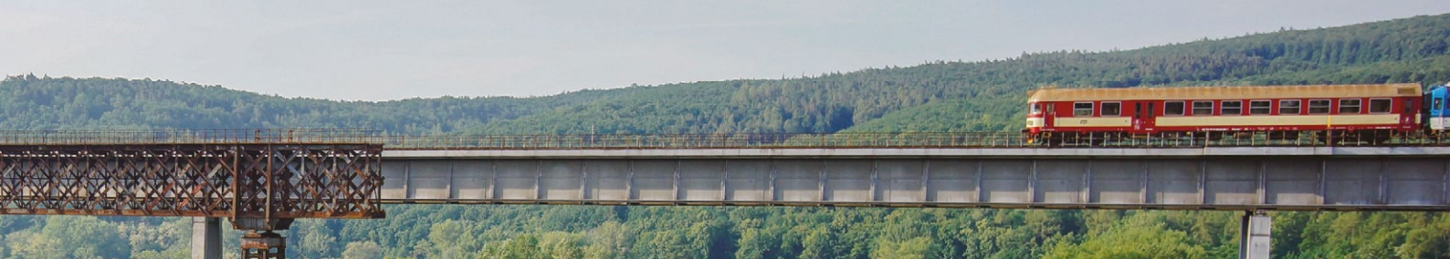
Železniční most v Ivančicích
